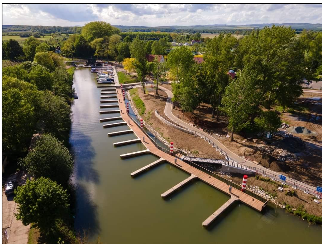
Obrázek 1.23 – Přístav Veselí n. Mor. po modernizaci v roce 2021 (Zdroj: ŘVC)
