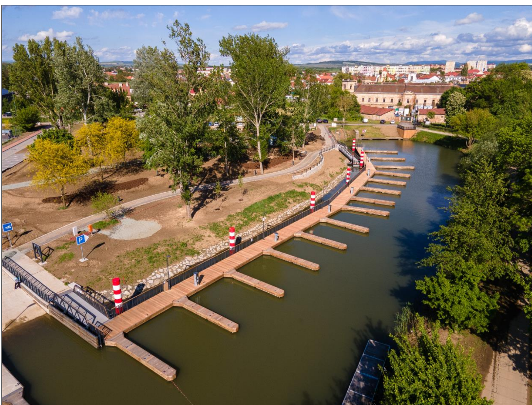
Obrázek 4.41 – Přístav Veselí n. Mor. po modernizaci (Zdroj: ŘVC ČR)
