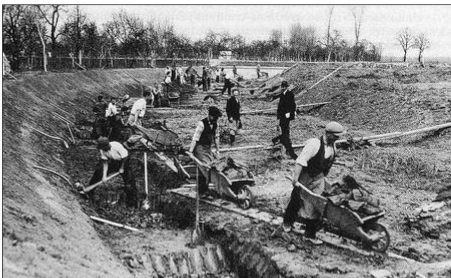
Obrázek 1.12 – Práce na korytě kanálu mezi Spytihněví a Uh. Hradištěm v dubnu r. 1935 (Zdroj: http://www.staremesto.uh.cz )
